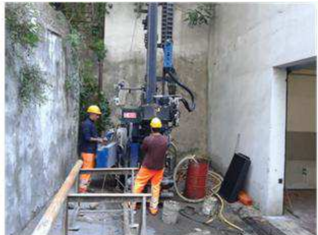
Posizionamento sonde di perforazione
