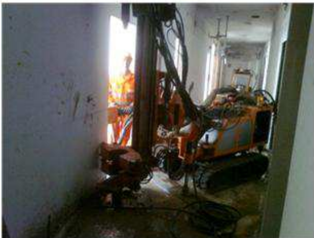
Posizionamento sonde di perforazione
