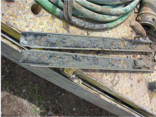
Catalogazione carote di sondaggio ed esecuzione di prove in situ
